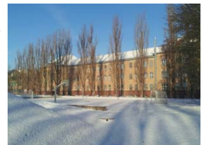
Haus D mit der Fachrichtung Geophysik auf dem Geocampus Lankwitz.
