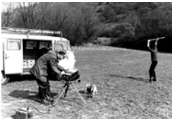
Einsatz der Hammerschlagseismik Anfang der 70er Jahre
