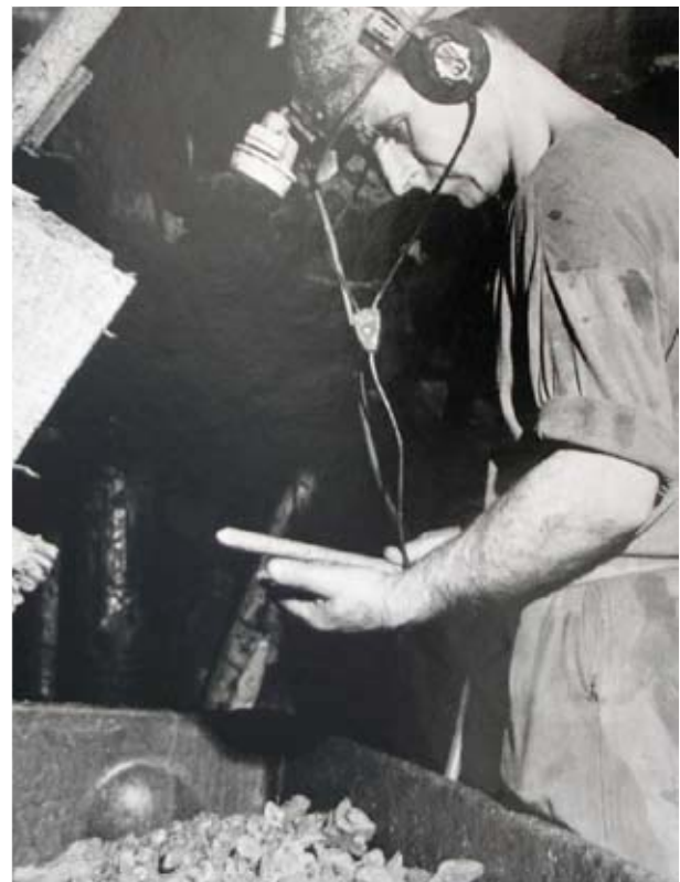
Abb. 3: Selektion der Uranpechblende vor Ort mit dem Hauerradiometer (vorn die Erzkruste, 1970er Jahre) (Fotos: Sammlungsbestand Museum Uranbergbau, Bad Schlemma)
